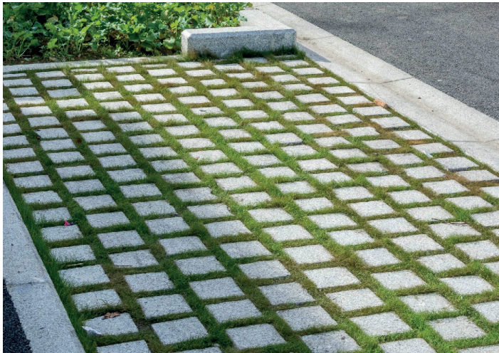
Parking en éco-pavés
