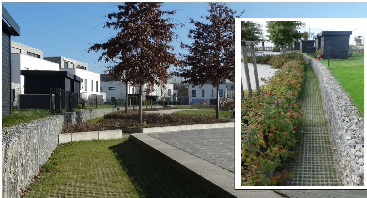
Photo 1 : Exemple d'un fossé servant à la collecter et à acheminer d'eaux pluviales vers un bassin de rétention et permettant l'infiltration des eaux dans le sol respectivement à l'irrigation des jardins adjacents. Lotissement à Bettembourg (L) « Cité du Soleil » Arch.: Architecture et Aménagement en collaboration avec le bureau d'études paysagiste BGHplan (de Trèves).
