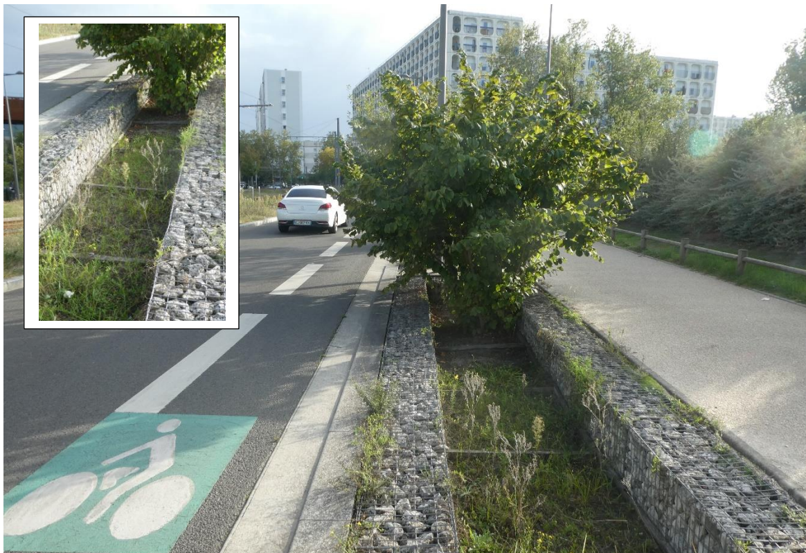
Photo 1 : Exemple d'un fossé servant à la collecte et à la rétention des eaux pluviales le long d'une route et d'une bande cyclable d'un côté et un large chemin piéton de l'autre. Tronçon du « Cr de Québec » aux abords du parc / espace vert du quartier écologique « Ginko » à Bordeaux (F).
