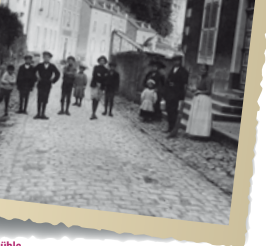
Pulvermühle 1914 © Photothèque Ville de Luxembourg
